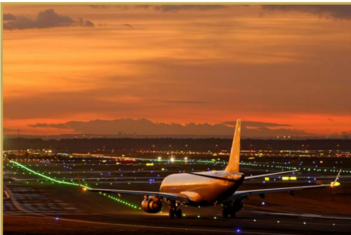
Exempel på en Taxibana på en flygplats. Gröna ljus används för centerlinje, blåa ljus för att markera kanterna på banan, röda ljus används för stopplinje.
