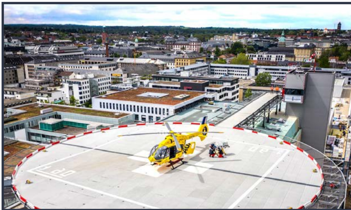
Helikopterflygplats på taket till ett sjukhus med TLOF och FATOljus installerade.
